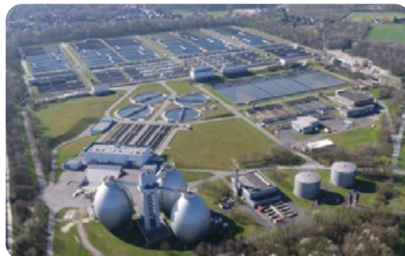
Estação de Tratamento de Esgoto Emscher-Mündung, na cidade de Dinslaken, Alemanha, essencial para tornar o Rio Emscher livre de emissões residuais.
