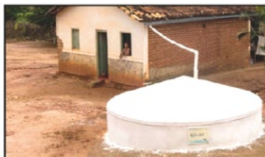
Figura 4. Cisterna de Placa – Construída pela Metodologia da ASA
