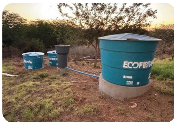
Figura 4 . Sistema de Reuso de água cinzas na Universidade Federal de Campina Grande em pleno semiárido do Cariri paraibano.
