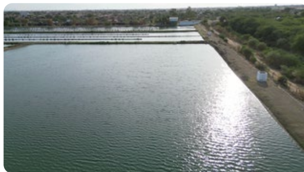
Estação de tratamento de esgoto em Juazeiro, BA – Sistemas de lagoas.
