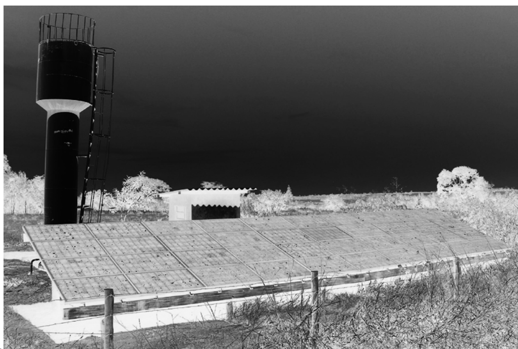
Figura 3: Sistema FV de Bombeamento instalado em assentamento agrícola no Município de Presidente Bernardes (SP). Motobomba nacional e unidade de condicionamento de potência WEG-Automação.
