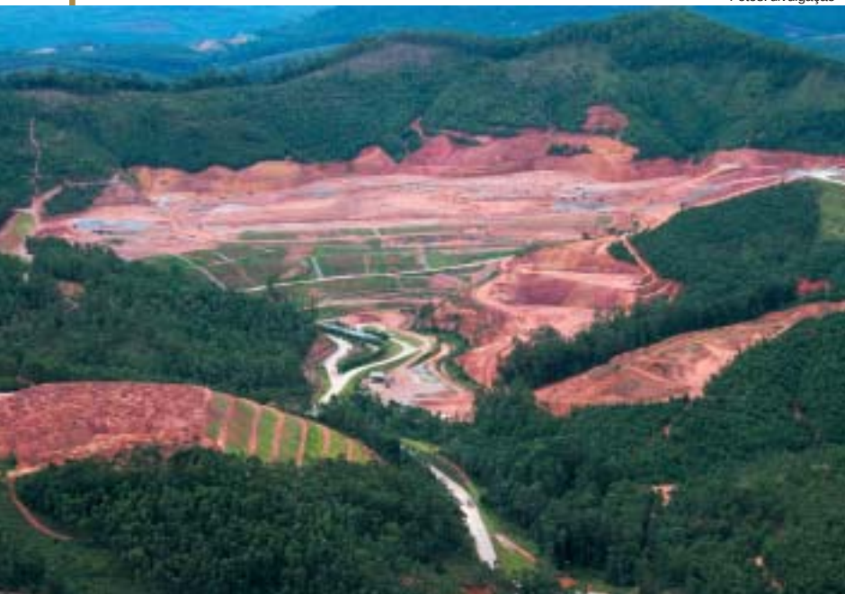
CTR de Caieiras: vista aérea
