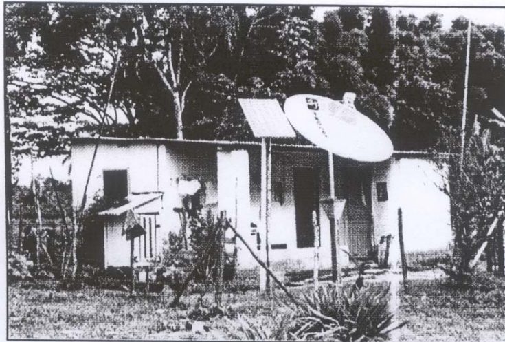
Sistema fotovoltaico instalado pelo mecanismo municipal na Ilha Comprida
