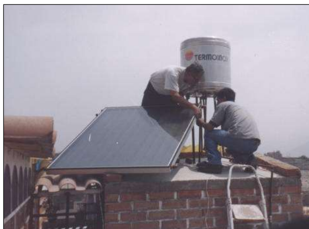
Figura 3.10. Montagem do coletor solar. [Foto: F. Morante, 2002]
