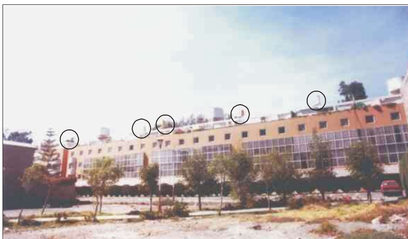
Figura 2.16. Aquecedor solar no setor comercial de Arequipa. [Foto: M. Salcedo, 2003]
