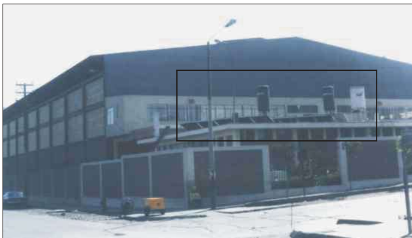
Figura 2.17. Aquecedor solar no setor industrial de Arequipa. [Foto: M. Salcedo, 2003]
