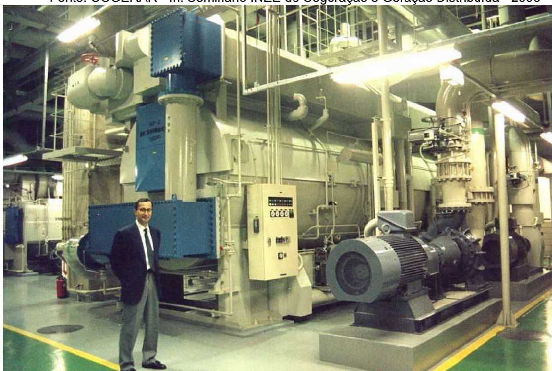
Fig. III.3 - CHILLER DE COMPRESSÃO CENTRÍFUGO MOVIDO A TURBINA A VAPOR Fonte: COGERAR - In: Seminário INEE de Cogeração e Geração Distribuída - 2003
