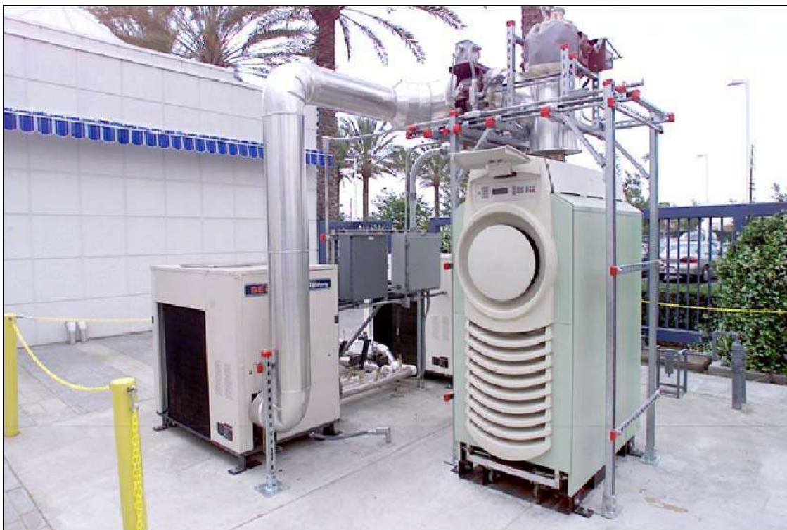
Fig. 2.17 - Unidade de Cogeração Eletricidade e Água Gelada por Absorção Capstone de 30 kWe.
