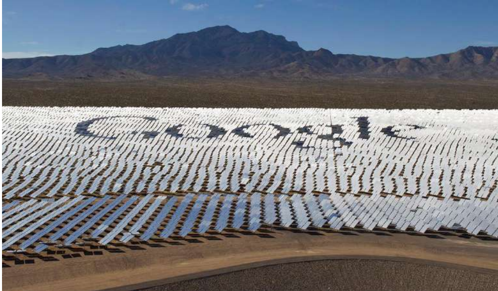
Figura 15.: Usina Ivanpah Solar Electric Generating System no deserto Mojave. Fonte: Google Green, 2014
