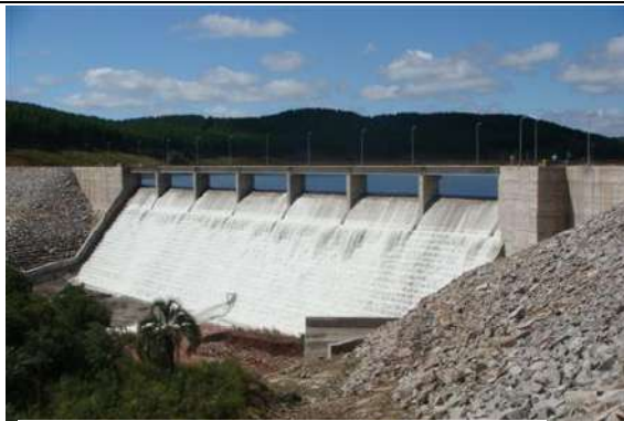
Figura 5.: PCH Passos Maia no rio Chapecó. Fonte: DESENVIX
