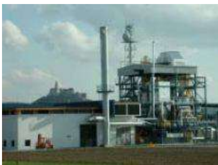
Figura 11. Planta de gaseificação Güssing, Áustria Fonte: LORA, 2007.
