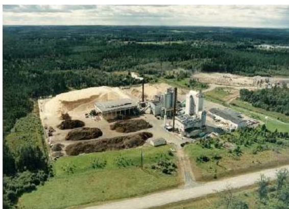
Figura 10. Planta de gaseificação Värnamo, Suécia Fonte: LORA, 2007.
