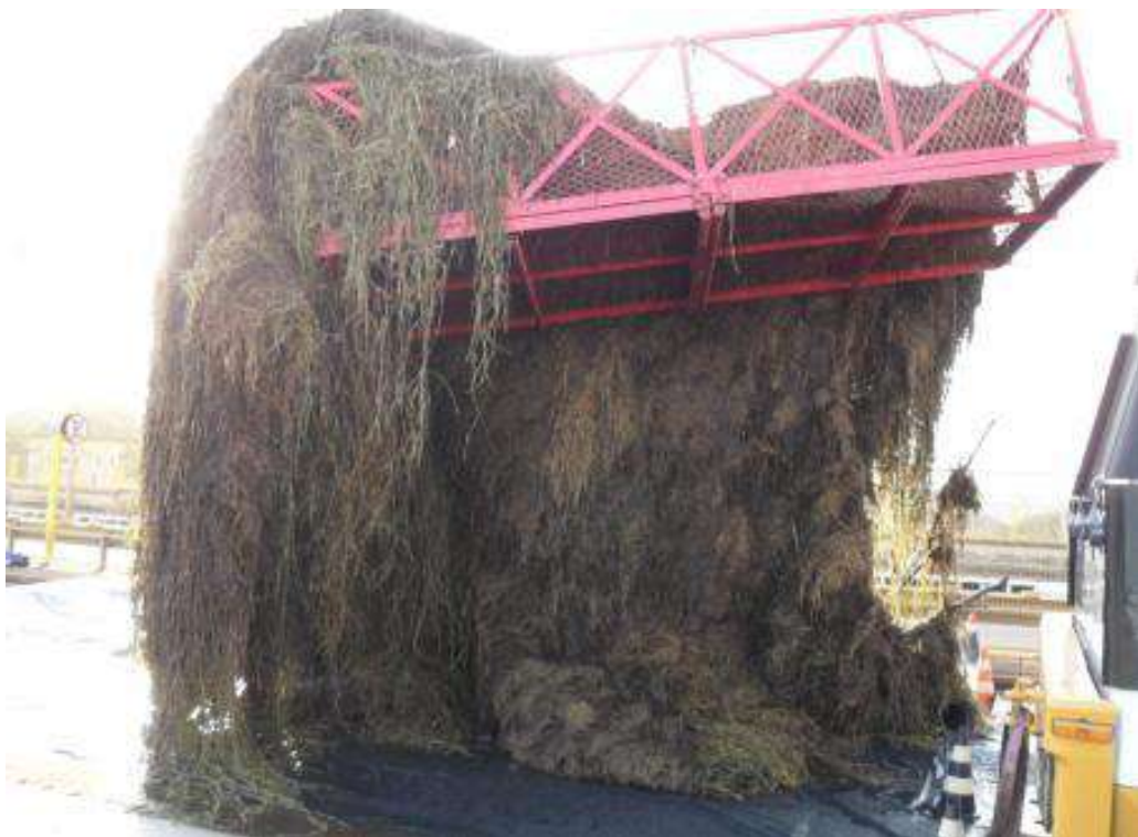
Figura 18 - Limpeza das grades de tomada d'água da UG01
