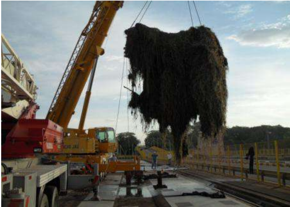
Figura 17- Guincho em operação de retirada de vegetação
