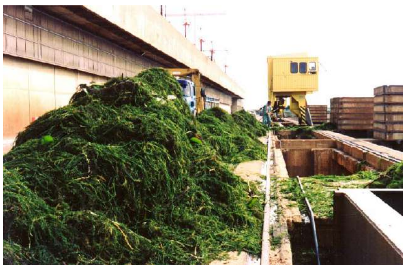
Figura 5 - Limpeza de macrófitas em usina hidroelétrica
