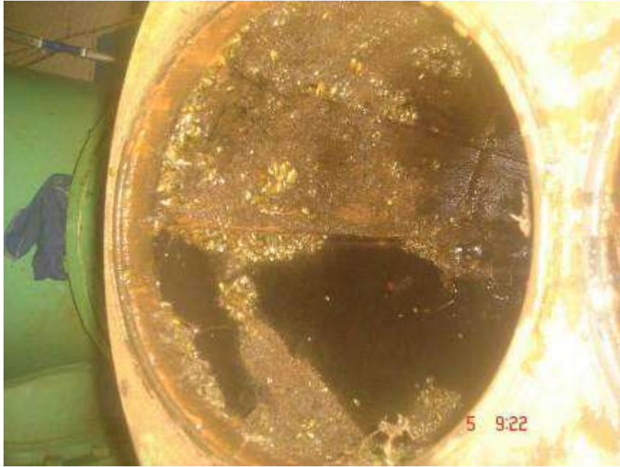
Figura 15 - Limpeza das tubulações do sistema de resfriamento principal da UG01
