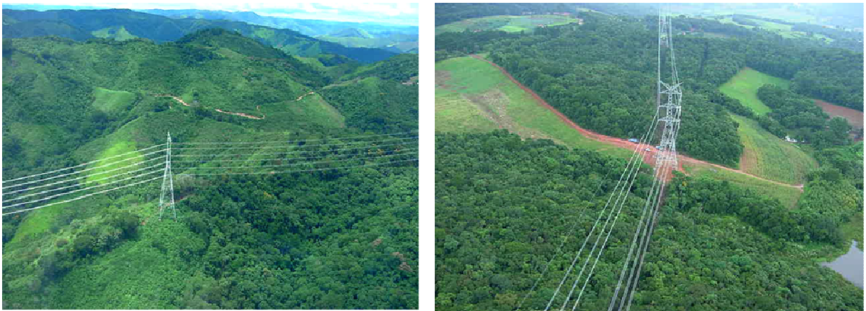
Figuras 14 - Ilustração da vegetação após lançamento de cabos
