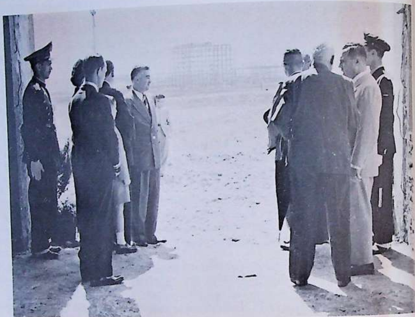
Inauguração do edifício de alta tensão pelo governador de Estado, Prof Lucas Nogueira Garcez (31/10/1952). Ao fundo, obras do edifício da antiga Reitoria da USP.
