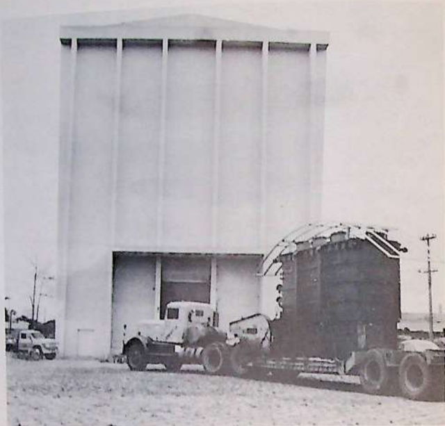
Transformador, de 20.000 kVA/138 kV, sendo entregue para ensaios de Alta Tensão.
