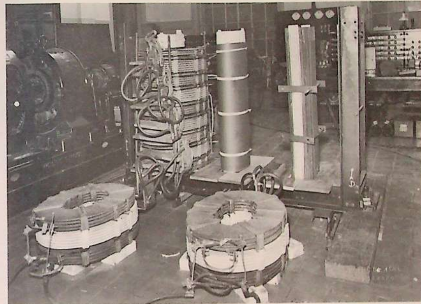
Transformador de 6.000 kVA sendo montado no IE (1943)
