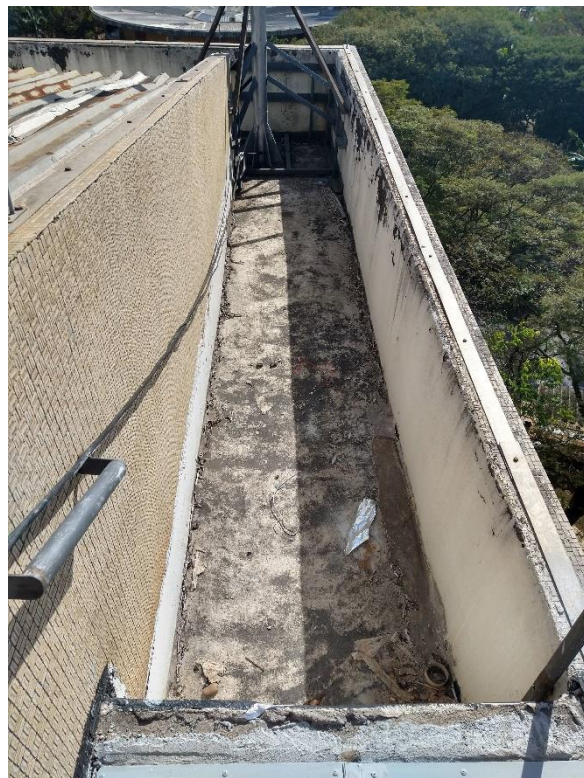
Figura 4 – Empena e platibanda
