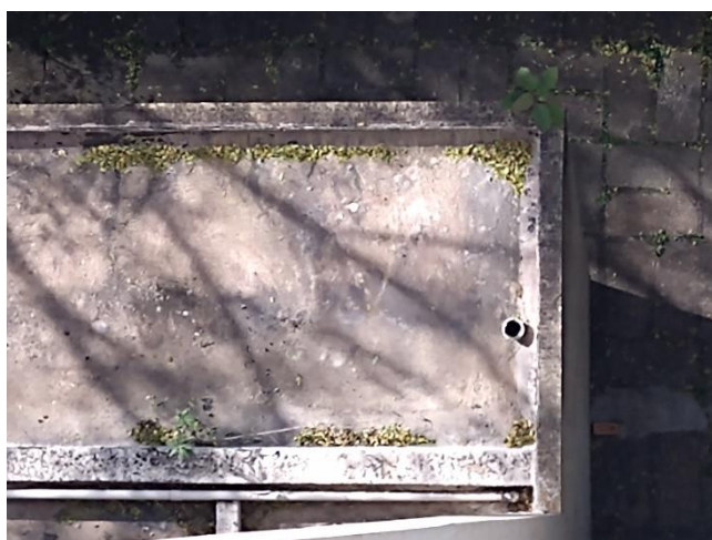
Figura 6 – Marquise da entrada principal
