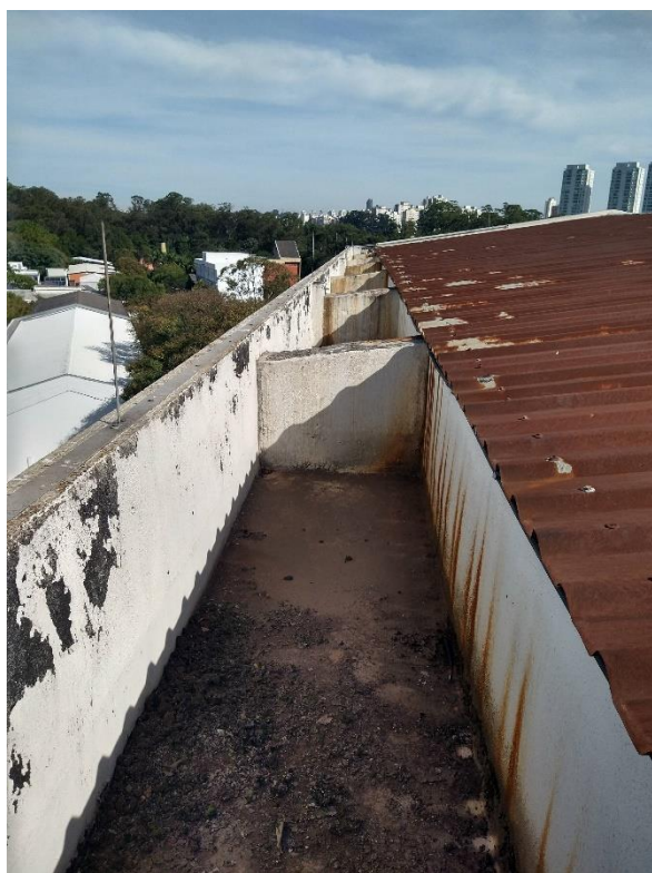
Figura 3 – Calha a ser impermeabilizada
