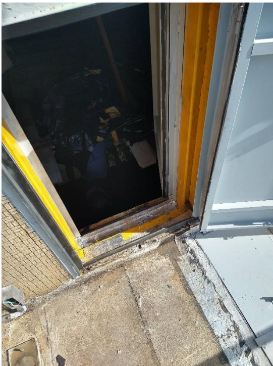
Fig. 9 – Portinhola sobre Caixa d' água
